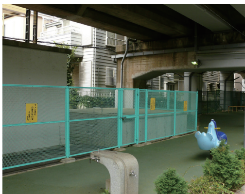
武蔵野線高架下の調整槽とポンプ小屋
